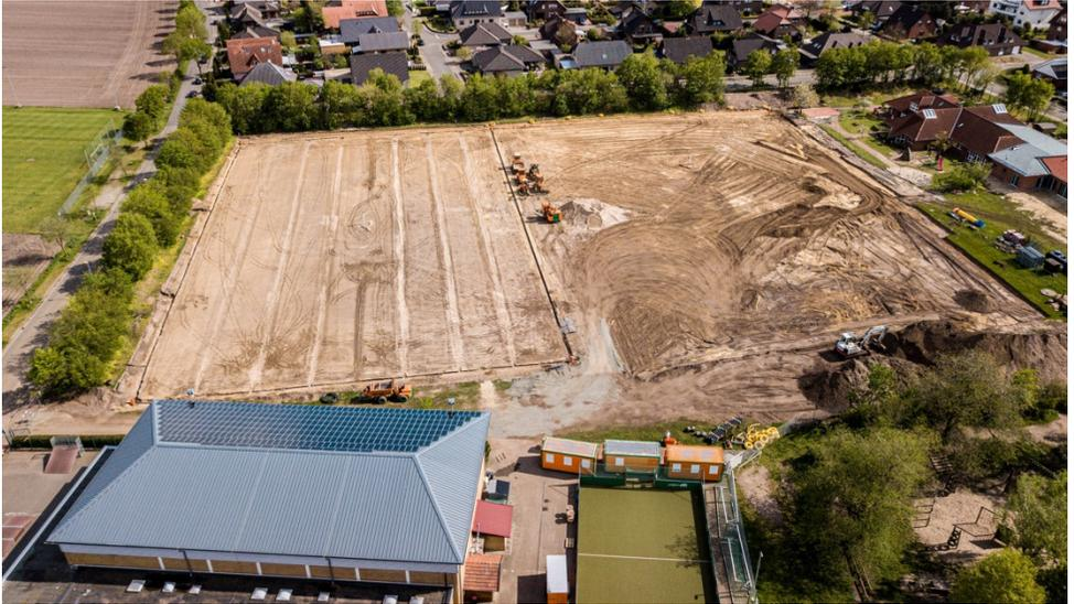
**Anfang Mai 2021** Drainage und Kabelschächte werden gegraben und das Erdreich wird mit unterschiedlichen Sanden aufgefüllt.
