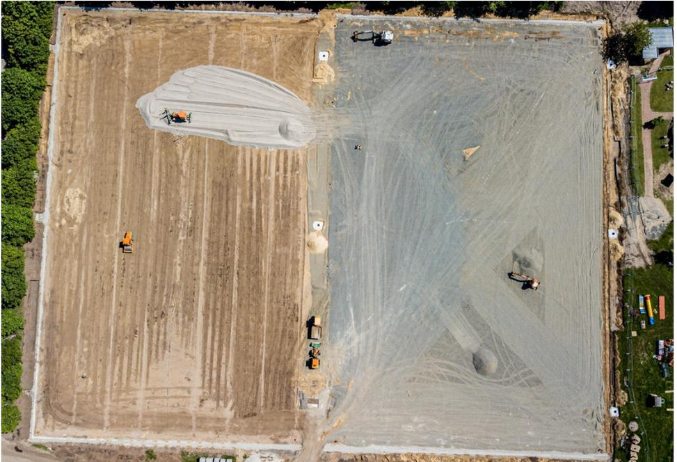
**Ende Mai 2021** Die Spielfeldumrandungen werden gepflastert, die Fundamente für die Flutlichtmasten ausgehoben und betoniert und die Erdarbeiten neigen sich dem Ende.
