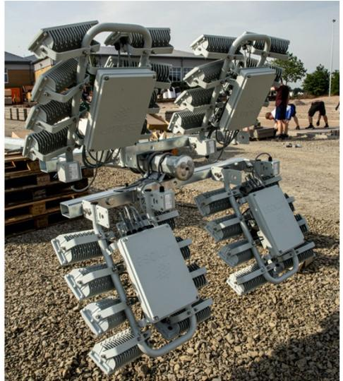
**Mitte Juni 2021** Die neuen LED-Flutlichtmasten werden zusammgebaut und aufgestellt.
